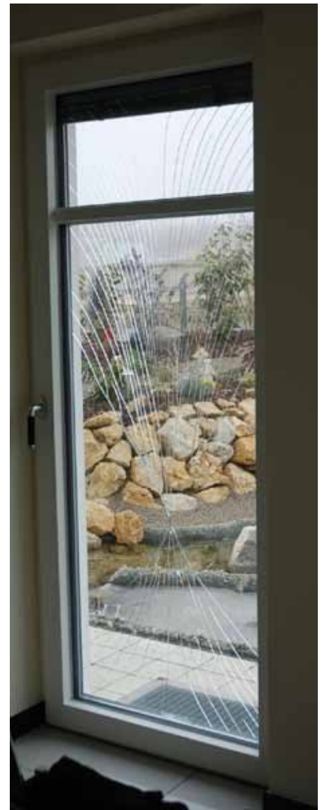
Flächendrucksprung bei Isolierglas mit großen Scheibenzwischenräumen.
