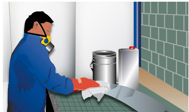
Abb. 21 Reinigen und Entfetten
