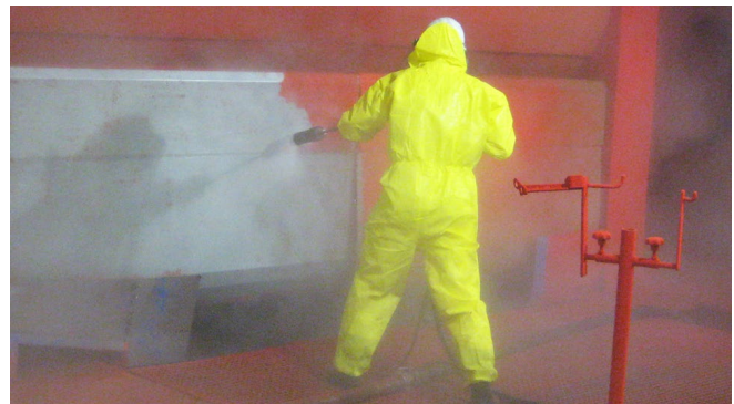
Abb. 20 Reinigung mit einem manuellen Hochdruckreiniger
